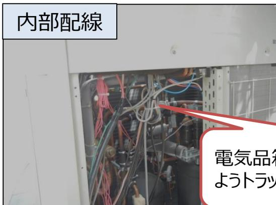
電気品箱に水が混入しないようトラップを設けてください。
